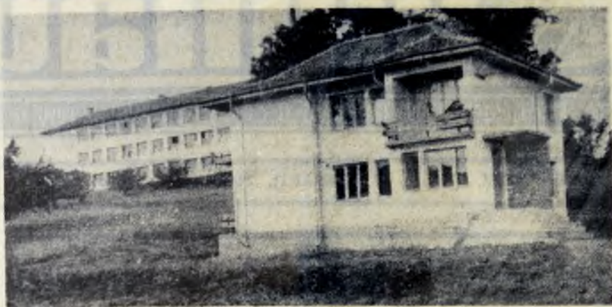
Construcții noi la Bălănești.
