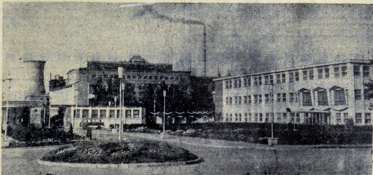
Arhitectură industrială la Combinatul de îngrășăminte cu azot Piatra Neamț.
